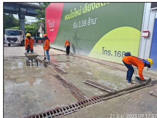
ภาพที่ 47 กิจกรรมขุดลอกตะกอนดิน
