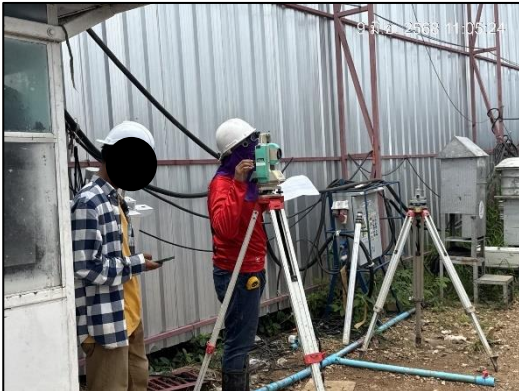
ภาพที่ 61 กล้อง TOTAL STATION
