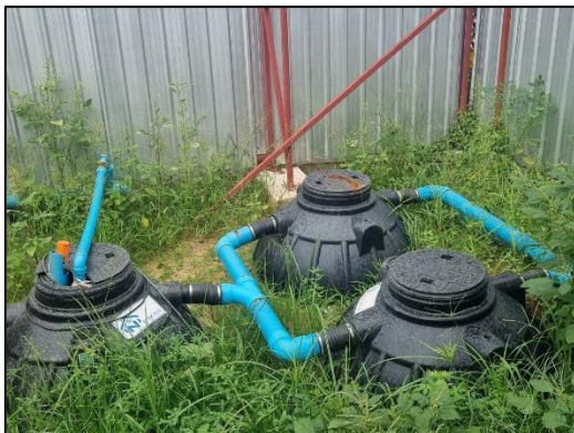
ภาพที่ 76 ระบบบำบัดน้ำเสีย
